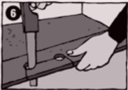
Für Rohranschlüsse werden Löcher gebohrt, deren Durchmesser ca. 20 mm größer sind, als der des Rohres. Nachdem die Diele verlegt ist, wird das Reststück eingesetzt. Die Abdeckung erfolgt nachträglich mit Rosetten.
